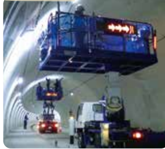
トンネル点検
