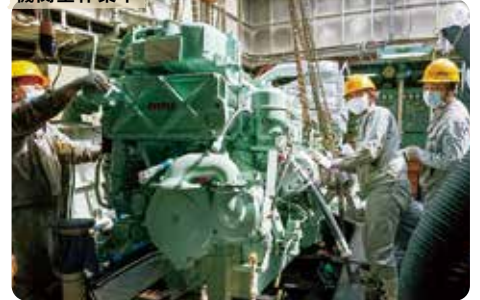
機関室作業中
