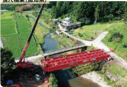
長尺橋梁(高知県)
