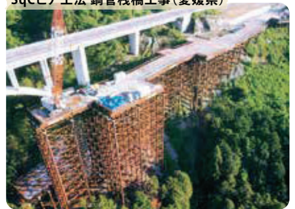
SqCピア工法 鋼管橋工事(愛媛県)
