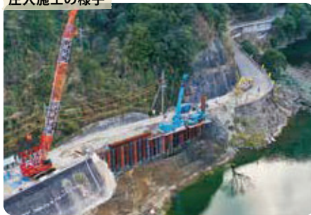
圧入施工の様子
