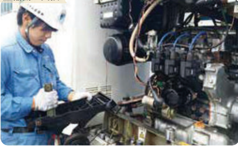
圧縮機の交換
