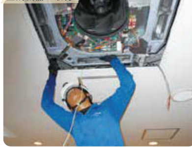
空調機器の取付
