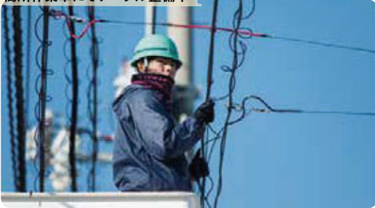
高所作業車にてケーブル整備中
