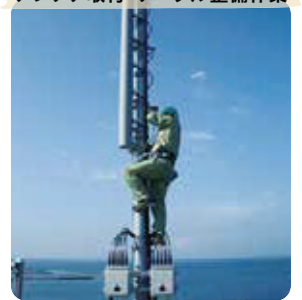
アンテナ取付・ケーブル整備作業
