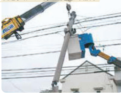
交通事故により折れた電柱を交換中
