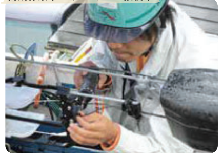
高所作業車にてケーブルを接続中
