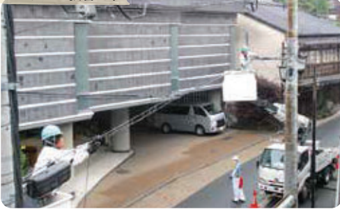
ケーブルの張替え中
