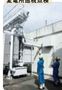
変電所巡視点検
