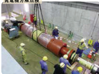
発電機分解点検
