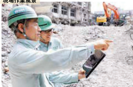
現場作業風景
