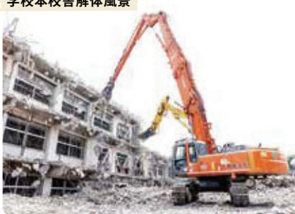
学校本校舎解体風景
