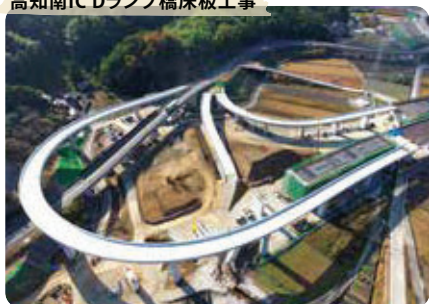
高知南ICランプ橋床板工事
