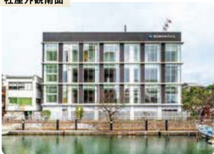
社屋外観南面
