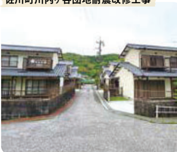
佐川町川内ヶ谷団地耐震改修工事
