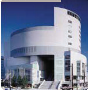
施工実績(かるぽーと)
