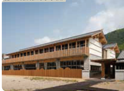
施工実績(伊野小学校)
