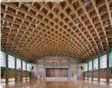
施工実績(久礼体育館)
