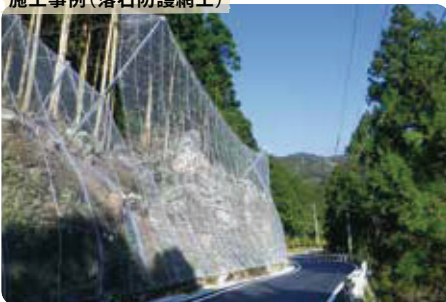
施工事例(落石防護網工)
