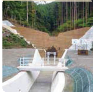
令和元-2年度天神谷堰堤工事
