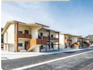
北川村共同社員住宅建設工事
