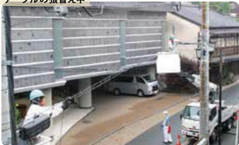
交通事故により折れた電柱を交換中
